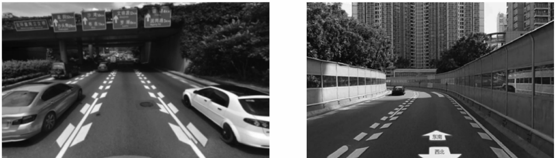
图 5 北环大道（皇岗立交段）快速路及春风快速路高架罗湖中学段增设纵向视觉减速标线示意
